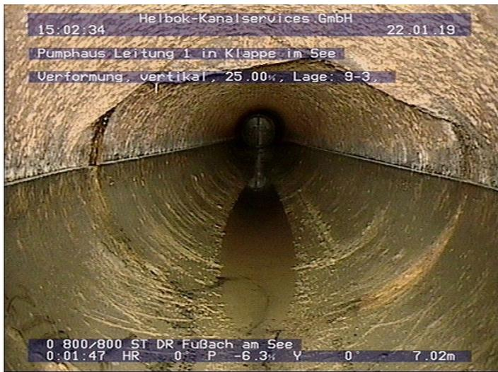
Die TV-Befahrung zeigt Deformationen, Rissbildungen und Korrosion an den Druckrohren...
