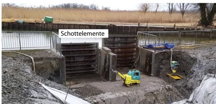
Um die alten Druckrohre gegen neue austauschen zu können, musste eine Dammöffnung und ein Aushub bis auf die bestehende Trasse durchgeführt werden. Das Öffnen und der Wiedereinbau (Schließung) des Damms wird geologisch und statisch begleitet.
