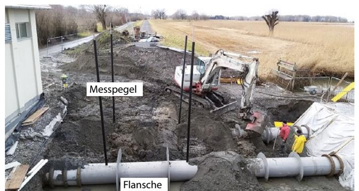
Die Rohre besitzen Flansche, welche in die Dichtschichten eingebettet werden. Beim Schließen des Damms sind beim Wiederaufbau entsprechende Überlappungen der Dichtschichten zum bestehenden Damm erforderlich. Um das Ausmaß eventuell eintretender Setzungen der Druckrohre festzustellen, wurden Messpegel eingebaut. Setzungsmessungen werden dann in entsprechenden Zeitfenstern durchgeführt.
