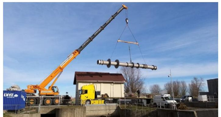
Die Druckrohre wurden auf der bestehenden Höhe –Trasse eingebaut. Sie wurden in Edelstahl erstellt, sind um die 15 Meter lang und besitzen einen Durchmesser von 80 cm. Beim Auslaufbauwerk wurden die Rohre in die bestehenden Stahlbetonwände einbetoniert.
