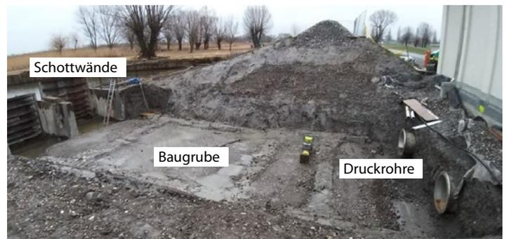
Das Bild zeigt die fertige Baugrube mit den Schottelementen sowie die Druckrohranschlüsse, welche im Zuge der maschinellen Ausrüstung bereits erneuert wurden.
